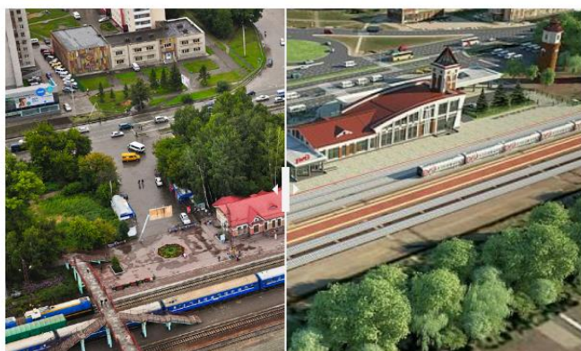
Рисунок 7 - Сопоставление фото зданий старого и нового вокзала г. Бердска в сервисе Knight Lab
