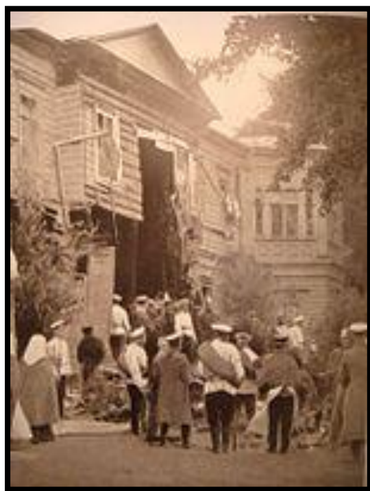
Разрушенное вследствие взрыва здание особняка.
